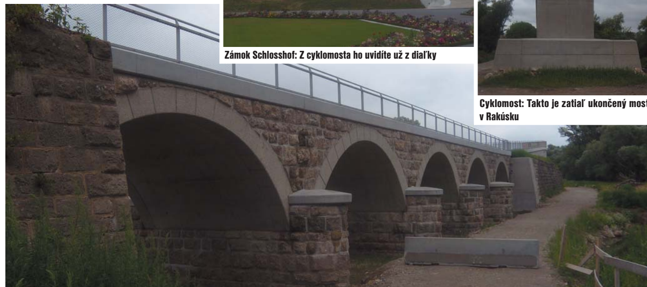
Most v Rakúsku: Je súčasťou cyklomosta do Devínskej N. Vsi. Je postavený na mieste historického mosta vybudovaného z čias Márie Terézie. Od zámku Schlosshof je vzdialený cca 400 metrov.
